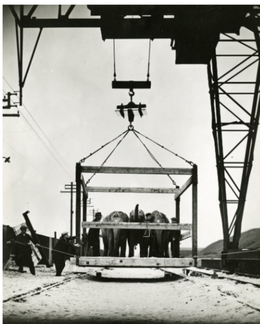
Test de résistance d'une glace Securit de 25 mm d'épaisseur au poids de deux hommes et de 3 éléphants réalisé en Angleterre, 1932 © DR / Archives de Saint-Gobain
