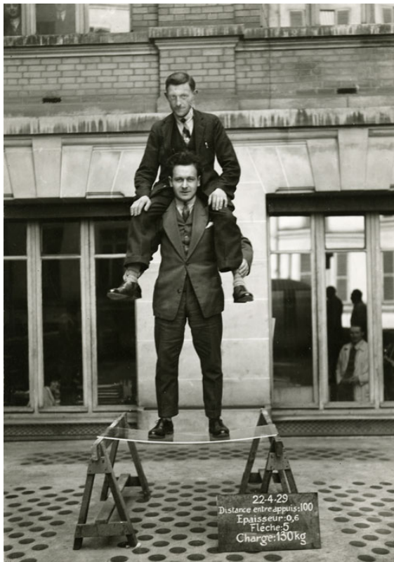
Test de résistance d'une glace Securit au poids de deux hommes (charge de 130 kg) devant les fenêtres du laboratoire de recherche de Saint-Gobain au siège social à Paris, 22 avril 1929 © DR / Archives de Saint-Gobain
