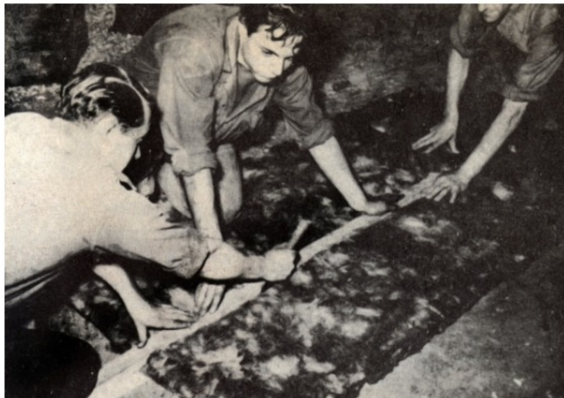
Pose des feutres pour l'isolation de la carrosserie par les Ets Mauduit-Lapierre à Pantin, 1948 © DR / Archives de Saint-Gobain
