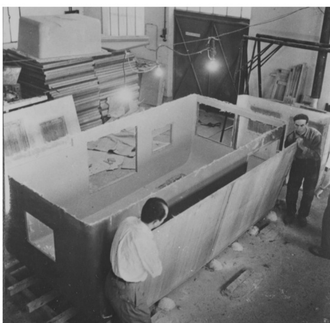
Montage des roulottes en polyester armé de fibre de verre, vers 1947 © DR / Archives de Saint-Gobain
