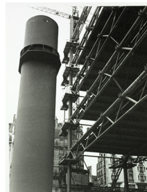
Construction du Centre G. Pompidou : tubes fabriqués à l'usine de Fumel vers 1974 © 1971-77 : Centre Georges Pompidou Paris, France / Client : Ministère de la Culture, Ministère de l'Éducation nationale / Studio Piano & Rogers, architectes / Archives de Saint-Gobain
