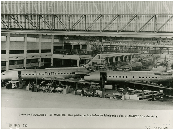
Usine de TOULOUSE - ST MARTIN. Une partie de la chaîne de fabrication des « CARVELLE » de série. N° 1 (P.1) TEL SUD - AVIATION Chaîne de fabrication des « Caravelle » à l'usine de Toulouse-St Martin. © Aerospatiale / Photo DR / Archives de Saint-Gobain
