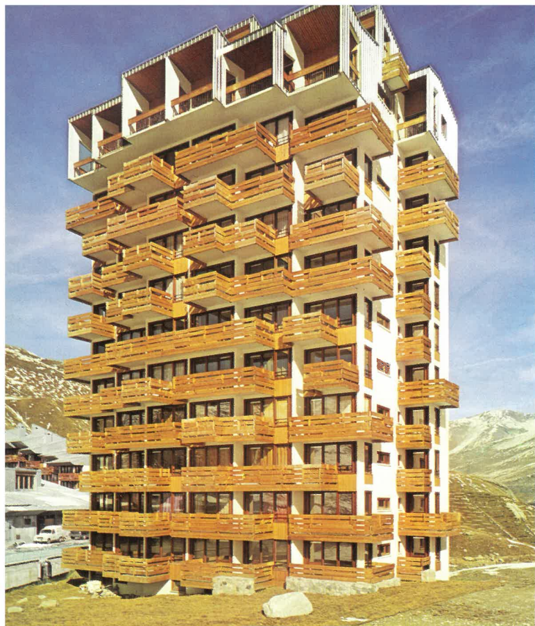
la Tour du Lac à Tignes (architectes : U.A. 5. - Atelier Urbanisme et Architecture : J. Appril/ P. Gebhart/C. Amann/J. P. Meyer)
